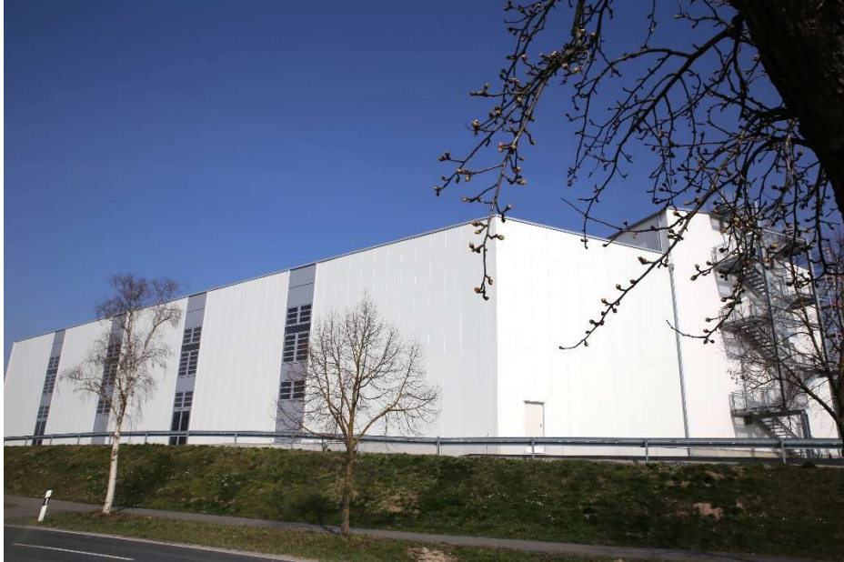
Das modifizierte Produktionsgebäude von Kräuter Mix ist nach dem Brand im Juli 2024 wieder komplett aufgebaut und saniert.
