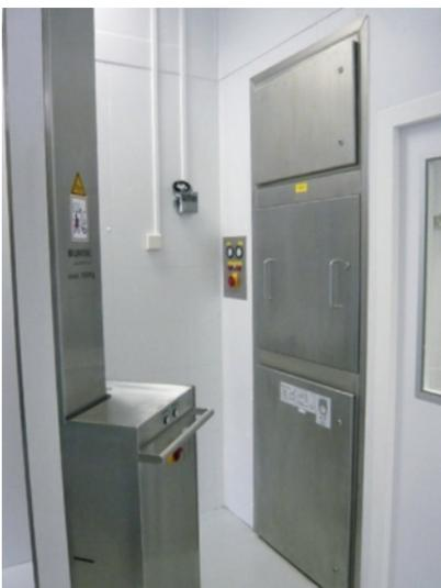
Abbildung 4: Filtersystem als Wandeinbau im Herstellbereich.
