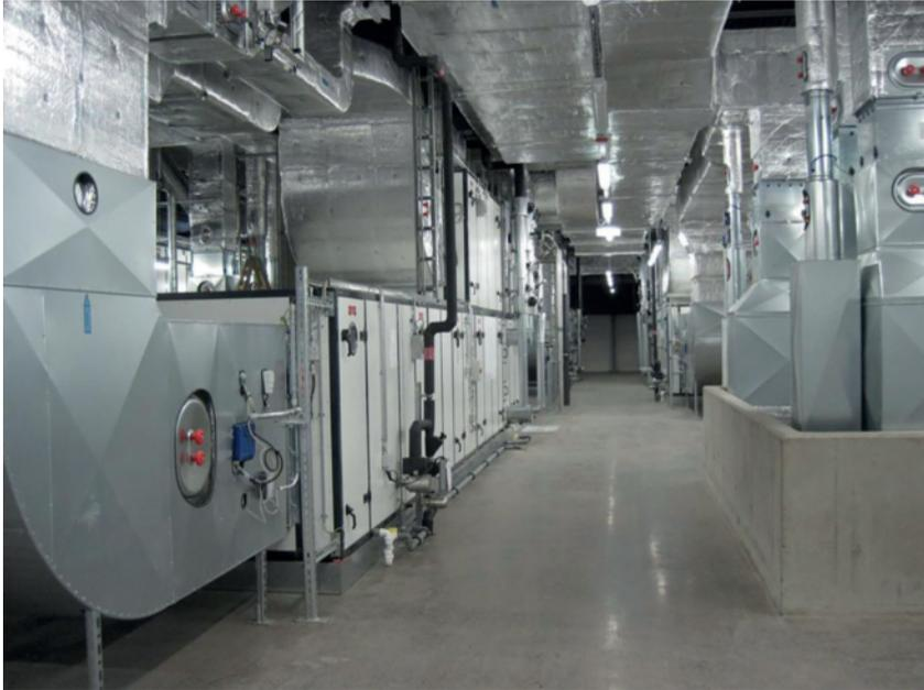
Abbildung 1: Lüftungszentrale in einem Pharmabetrieb (Quelle der Abbildung: Behrens Projektmanagement GmbH).
