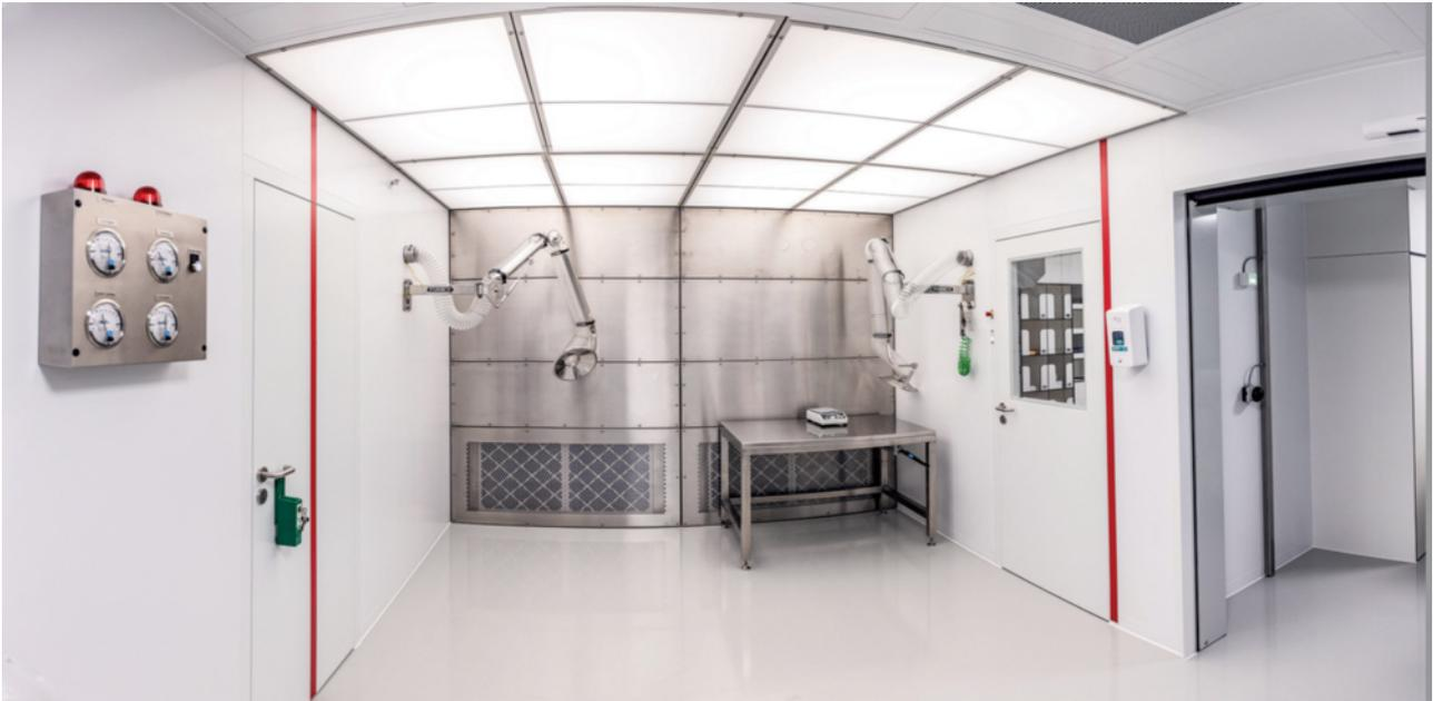
**Abbildung 3: Reinraum zur pharmazeutischen Probenahme mit Laminar-Air-Flow-System und Schleusensystem.**
