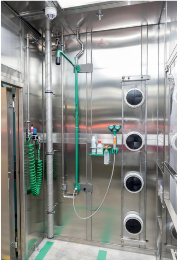
**Abbildung 4: Installation einer Körper- und Augendusche im Musterzug in unmittelbarer Nähe zur Beprobung.**
