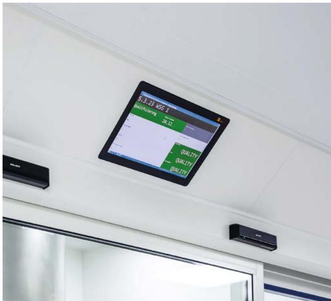
Foto: HMI-System CONTROL FLUSH-MOUNTED, flächenbündig integriert in Reinraumwand
